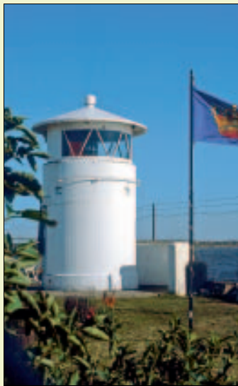
Klein aber fein: Leuchtturm Strukkamphuk
