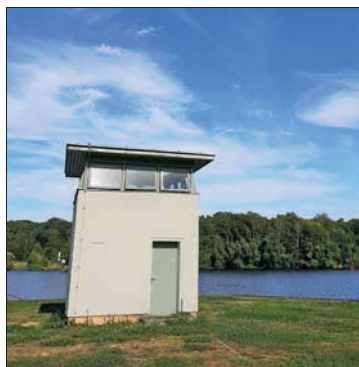
Ehemaliger DDR-Wachturm an der Bertinistraße
