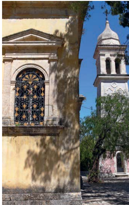
Der Glockenturm wurde originalgetreu wieder aufgebaut
