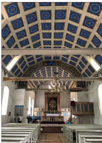
Das Tonnengewölbe in St. Petri
